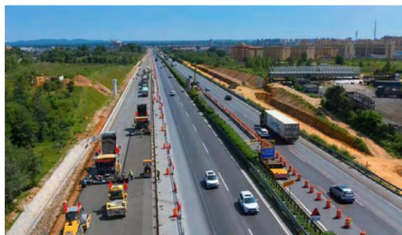
**北京至哈尔滨高速公路绥中至盘锦段改扩建工程全面打造“平安百年品质工程”：**项目突出长寿命路面设计理念，推行 3D 摊铺、双层连铺，采用“横向喂料”“大厚度摊铺”等技术，强化路面质量控制，全力打造全国长距离多车道高速公路改扩建工程示范标杆。
