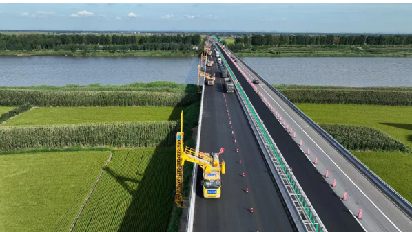
桥梁维修加固
