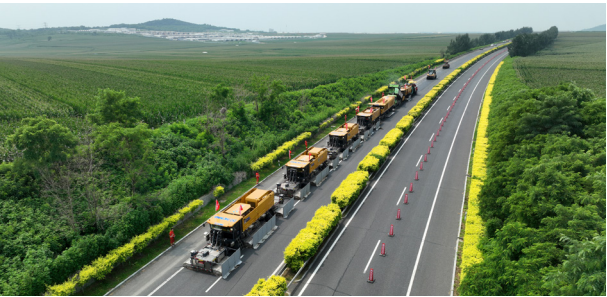
养护作业就地热再生技术节能环保
