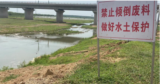
水源地警示标牌
