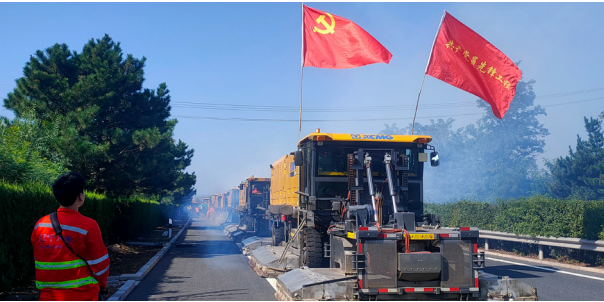
现场热再生技术
