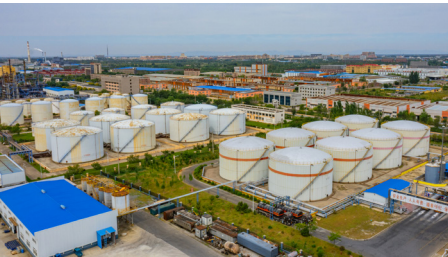
集团下属物资公司沥青储罐
