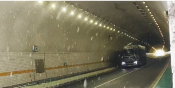
采用隧道随车照明控制技术车辆通行
