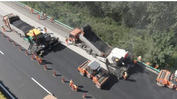
京哈高速沈阳至盘锦段公路养护维修
