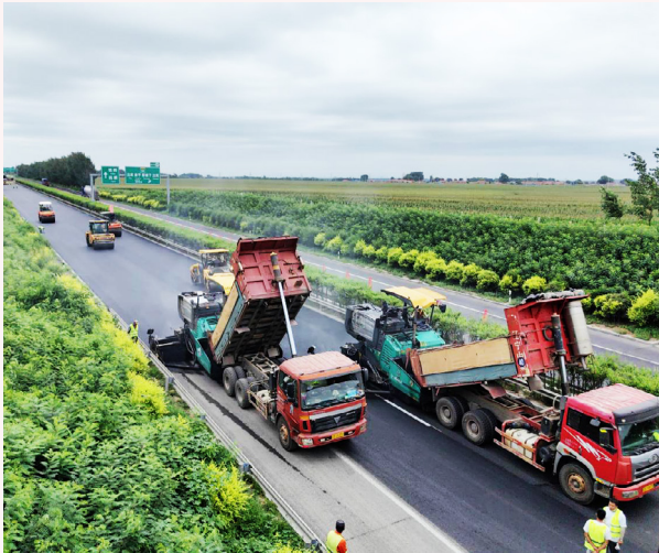
辽宁中部环线新铁高速公路路面预防性养护工程超薄磨耗层施工
