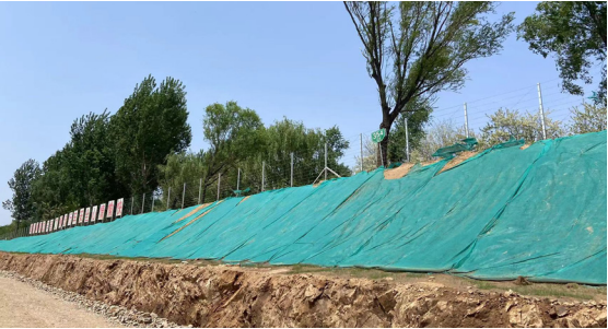
土方覆盖减少扬尘
