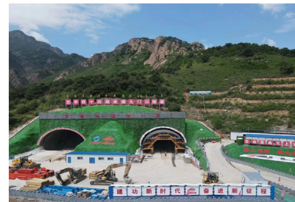
隧道口实施绿化措施
