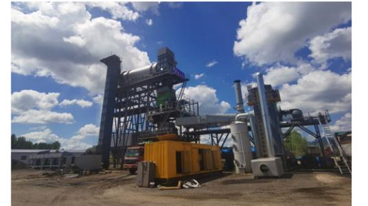
阜锦高速公路路面养护维修项目建成投用国内首台环氧改性沥青再生拌和站
