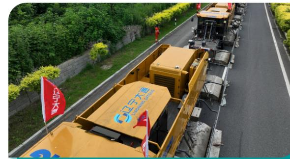
《沥青路面固废资源化高效循环利用成套技术与装备研发》项目研究成果就地热再生在辽宁省平康高速公路、长深高速公路、辽开高速公路、新铁高速公路等路面维修养护工程实现大规模应用
